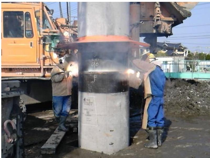
図-8 急な降雨時の防護例
